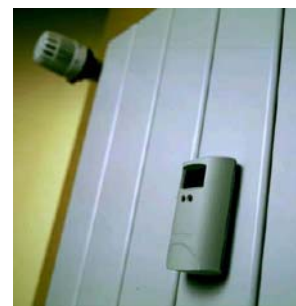
Fig.2 – Montaggio del ripartitore di calore
